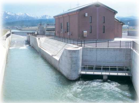
七ヶ用水発電所(石川県・手取川水系手取川)
