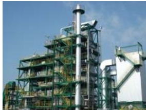
木質バイオマス発電所
