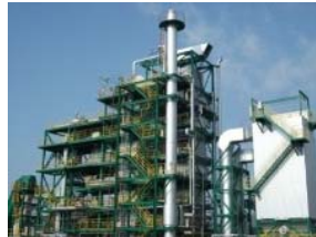
木質バイオマス発電所
