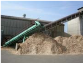
木質チップ製造施設
