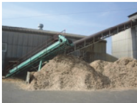
木質チップ製造施設
